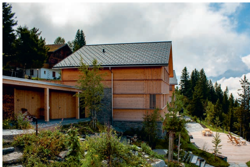
Für die Terrassen wurde Lärchenholz eingesetzt. Auffällig ist die horizontal gegliederte Fassade.
