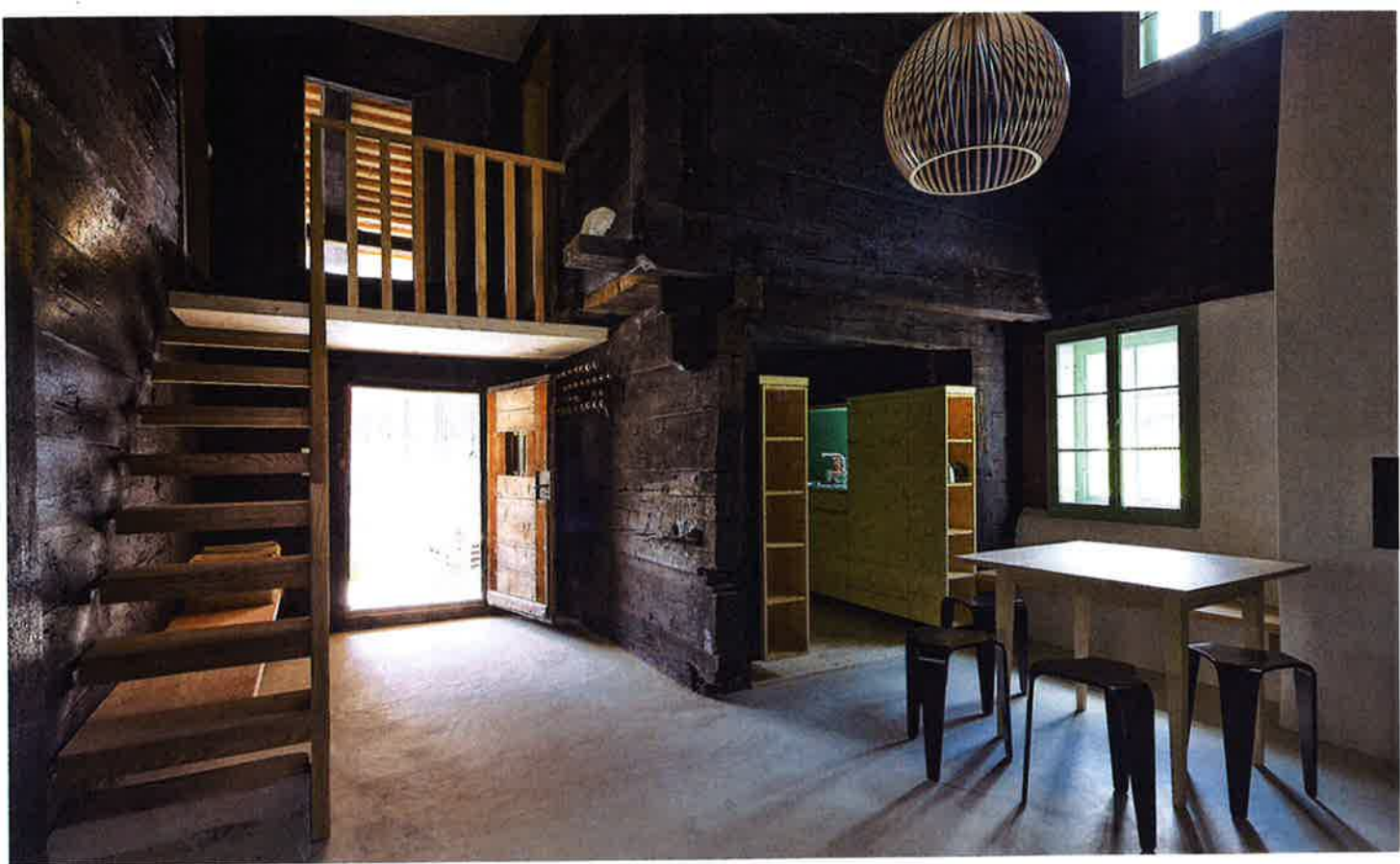
Früher hatte das Haus keinen Kamin, der Rauch zog einfach durch die Schindeln des Daches ab. Nach der Renovation erhielt die Küche, die richtigerweise darum den Namen Rauchküche trägt, die ursprüngliche Höhe von 4 Metern zurück.
