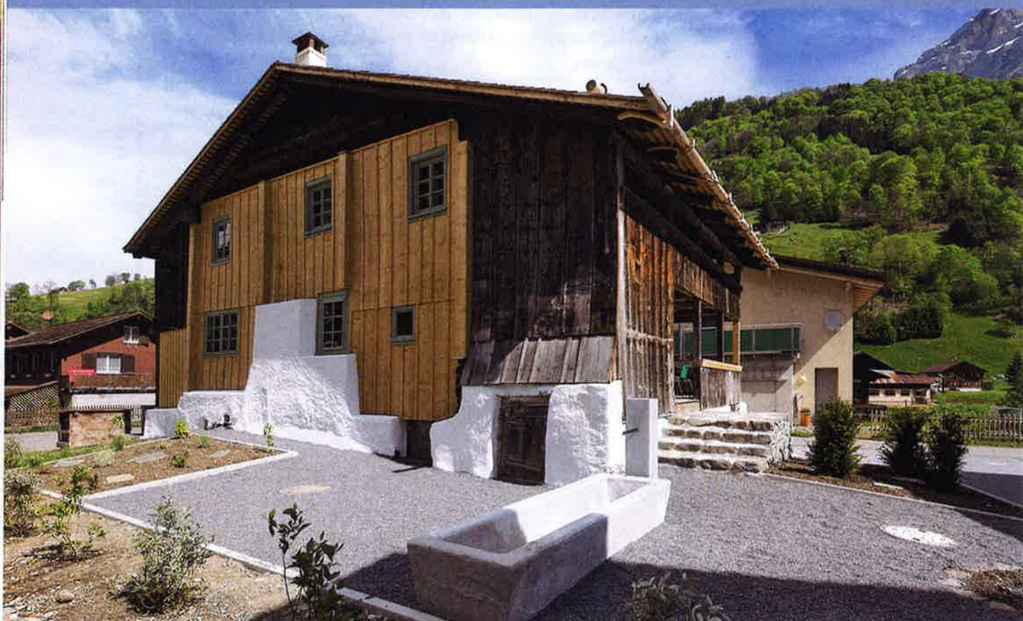
Bei der Südfassade musste schadhaft gewordenes Holz teilweise ausgetauscht werden.
